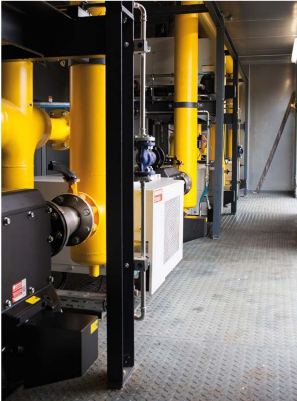
Extrem effizient, wegweisend in der Technik, sicher: Anlagen wie die in Seelow sind hochmoderne Industriestandorte für die Produktion umweltfreundlicher Energie.
